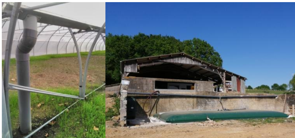
Photo 1 : gouttière collectant l'eau de pluie d'un bitunnel / Photo 2 : réserve d'eau connectée à la gouttière du hangar dans une ancienne fosse à fumier
