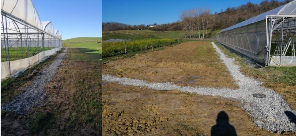
Photos : drain enterré autour des serres au GAEC Petrichor
