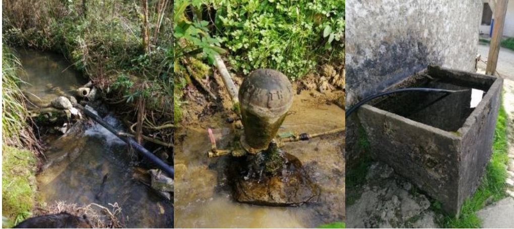
Photo : pompe bélier et abreuvoir alimenté 70m plus haut
