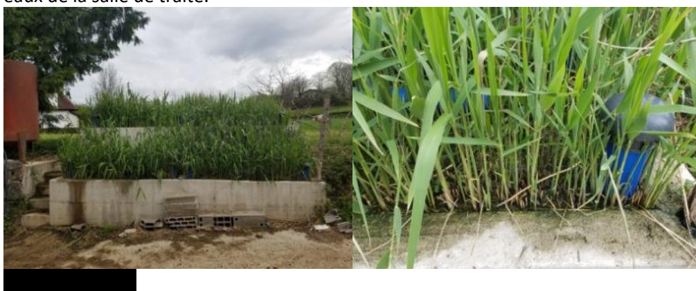
Photo 1 et 2 : phytoépuration sur une ferme en vaches laitières
