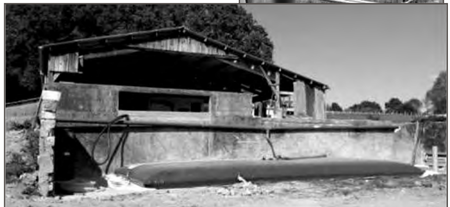
Gouttière collectant l'eau de pluie d'un bi-tunnel (au-dessus) ; réserve d'eau connectée à la gouttière du hangar, dans une ancienne fosse à lisier (en dessous).
